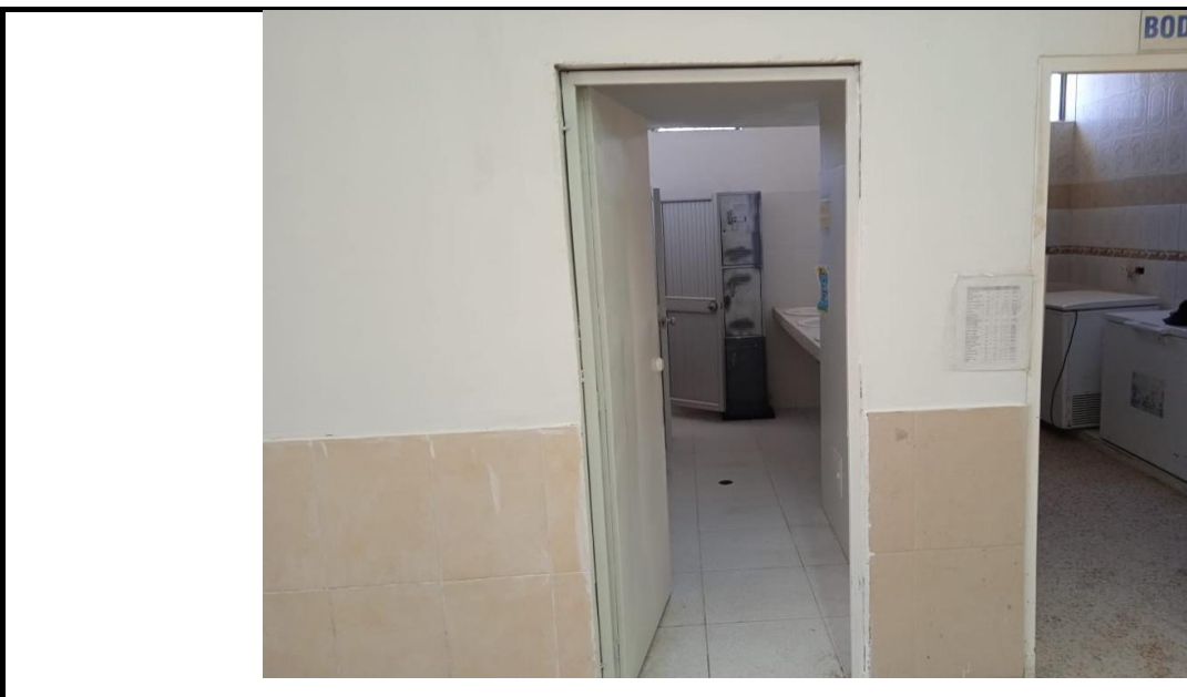
AMPLIACION VANO DE PUERTAS BAÑOS VISITA 2
