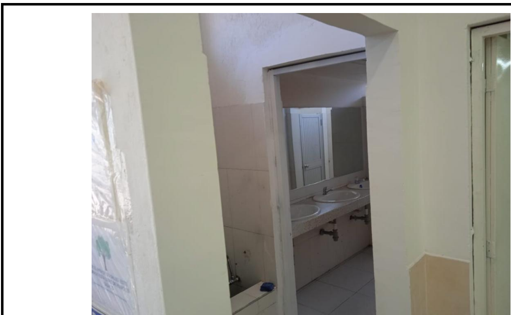
AMPLIACION VANO DE PUERTAS BAÑOS VISITA 2
