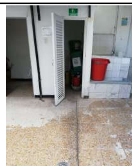
DESCRIPCION: SHUT DE BASURAS Y PATIO
