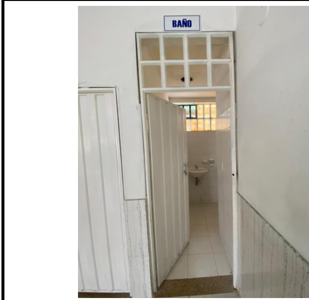
DESCRIPCION BAÑOS FUNCIONARIOS
