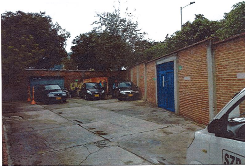
MURO DE CERRAMIENTO EXISTENTE
