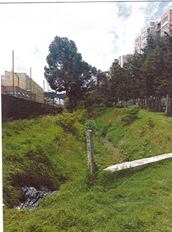
CANAL DONDE SE ENCUENTRAN SALIDAS DESAGUES
