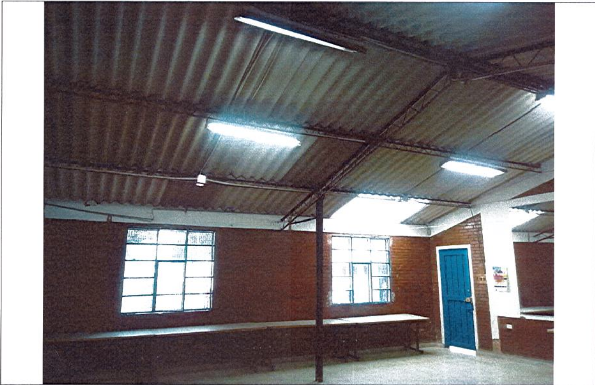
CUBIERTA A INTERVENIR INTERNA
