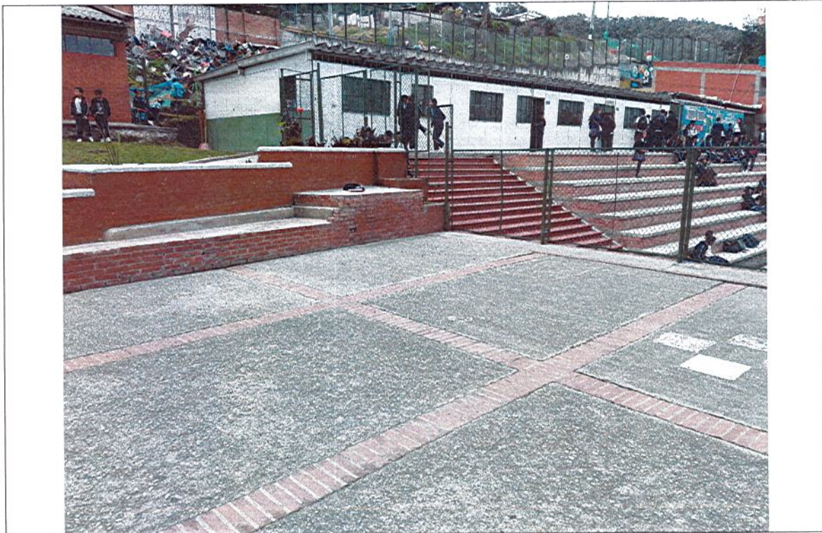
BLOQUE DE AULAS A INTERVENIR
