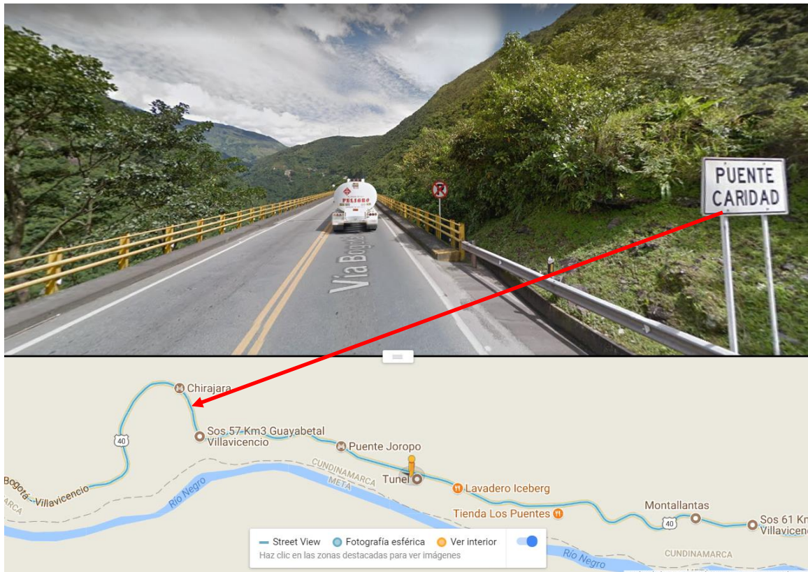
Figura 1.1. Localización del puente Caridad entre el PR 63+708.35 y el PR 63+958.75 de la carretera Bogotá-Villavicencio
