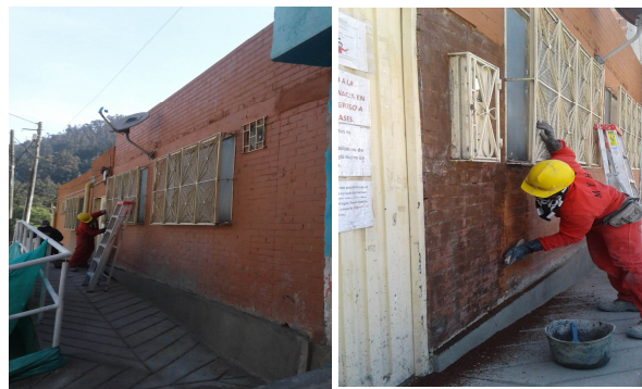
LIMPIEZA DE FACHADA
