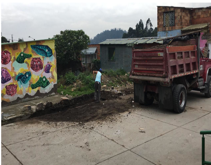
RECOLECCIÓN DE ESCOMBROS
