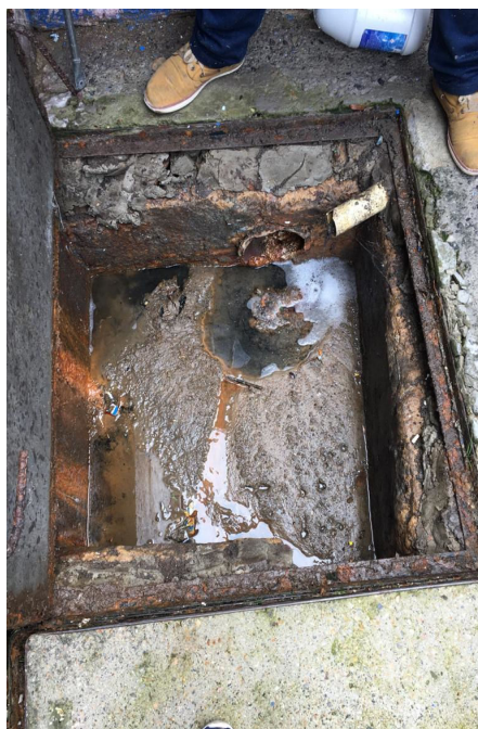
LIMPIEZA A CAJAS DE INSPECCION
