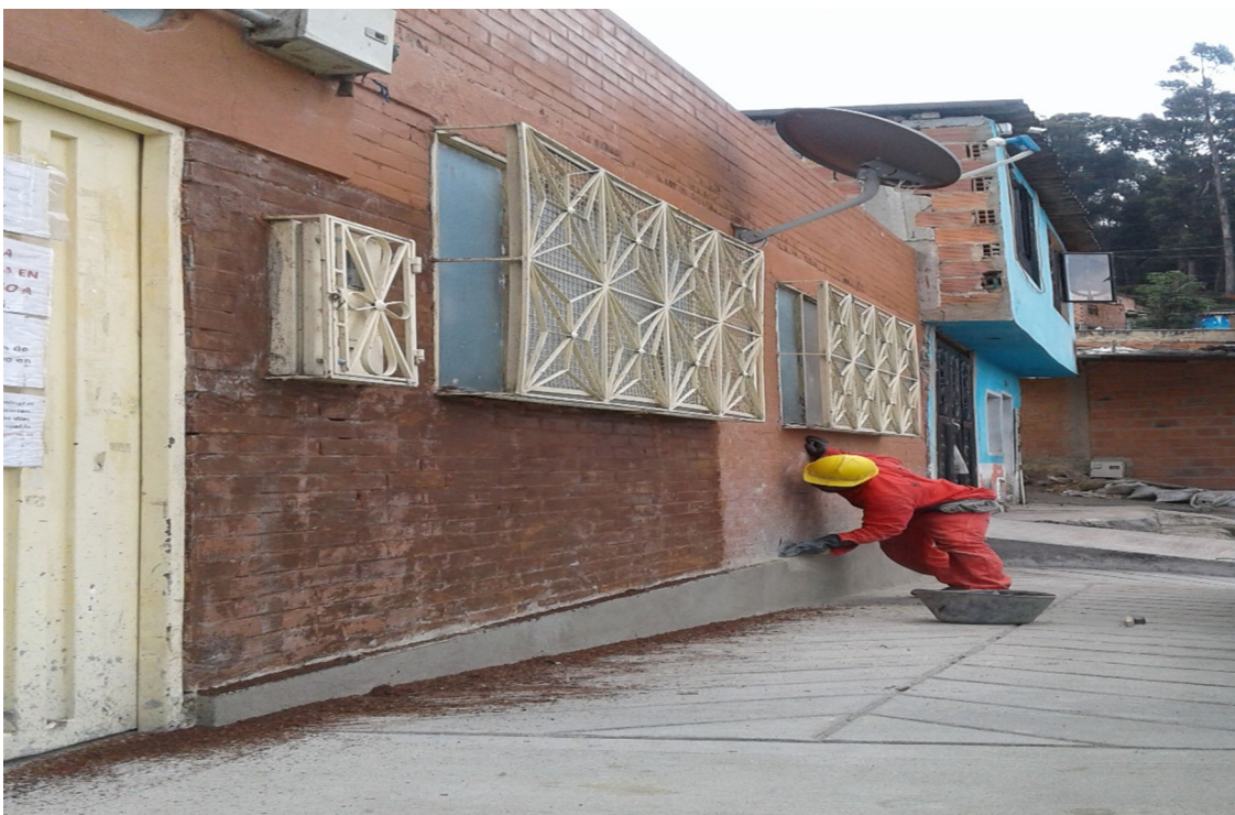
LIMPIEZA DE FACHADA PRINCIPAL
