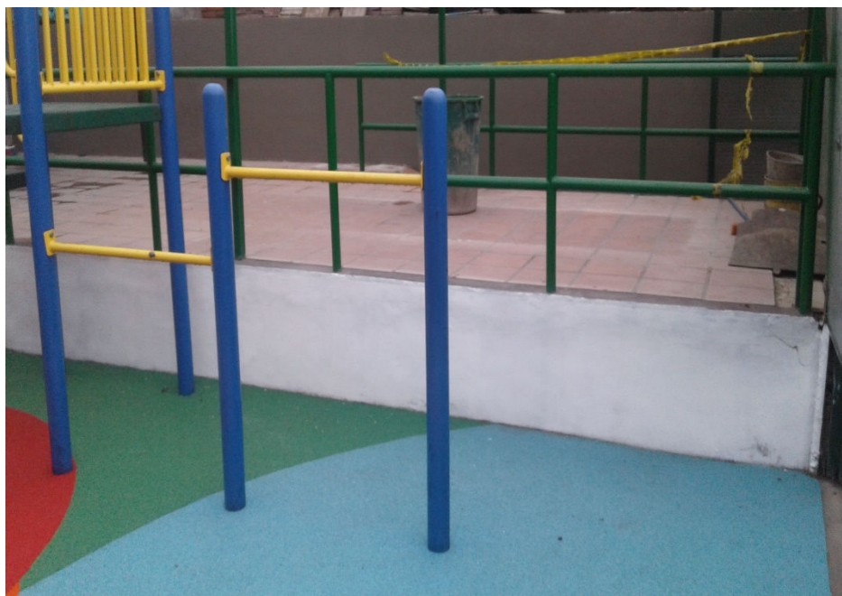
PINTURA EN MUROS INTERNOS – ZONA DE JUEGOS
