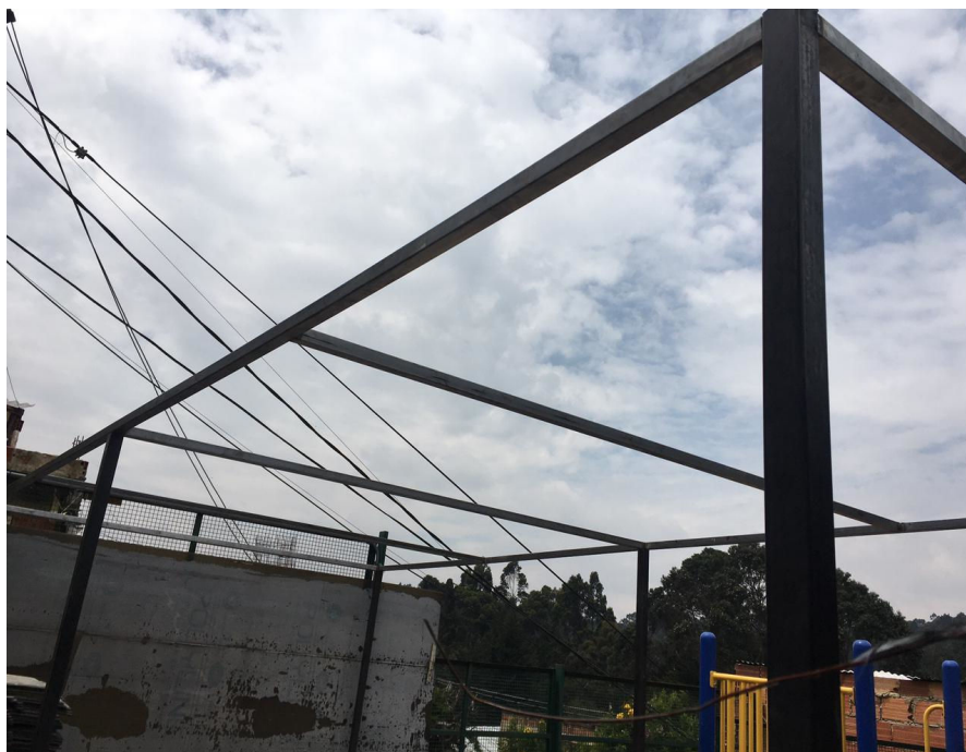
CONSTRUCCIÓN DE ESTRUCTURA DE CUBIERTA – ZONA DE JUEGOS
