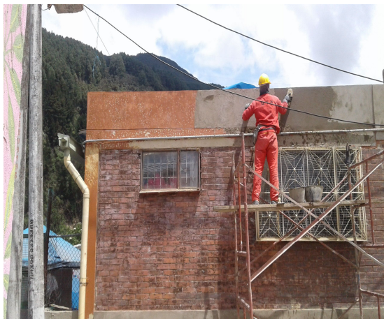
ESCARIFICADO EN TRAMO DE FACHADA
