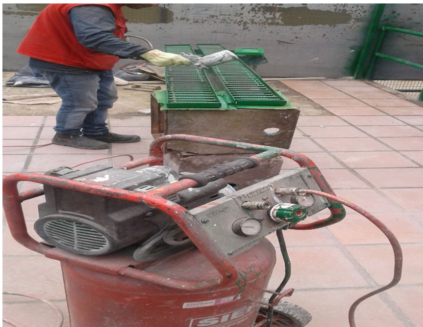
PINTURA DE ESMALTE SOBRE REJILLAS DE CARCAMO
