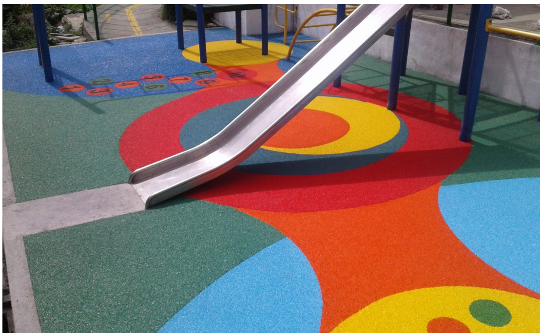
ACABADO FINAL PISO CAUCHO
