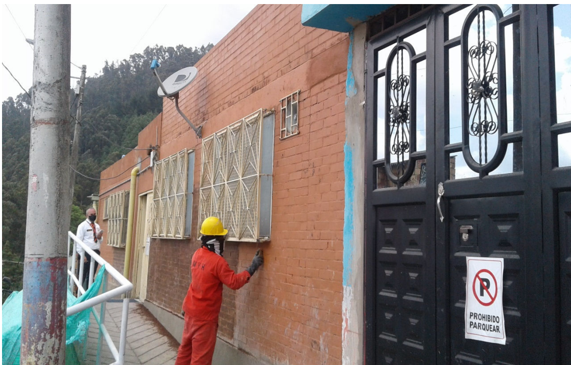
LIMPIEZA DE FACHADA PRINCIPAL
