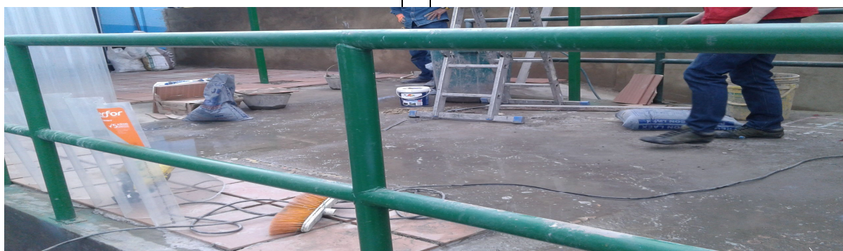
INSTALACION DE TRAMO DE BARANDA
