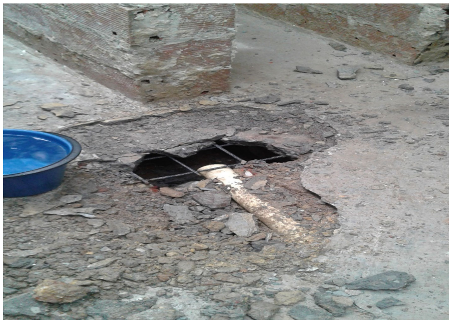
DEMOLICION DE PISOS
