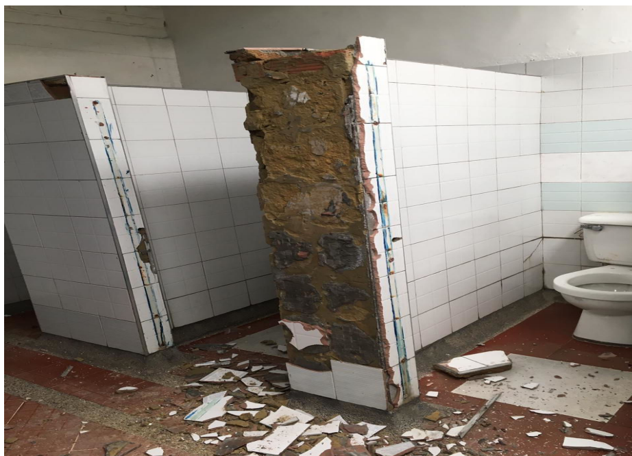
DESMONTE DE PUERTAS CABINAS SANITARIAS
