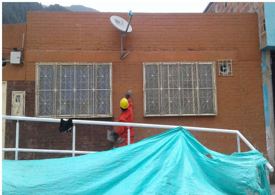
LIMPIEZA DE FACHADA PRINCIPAL
