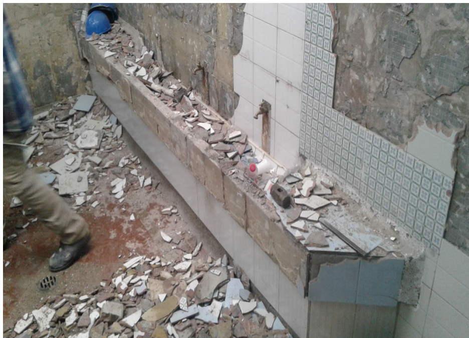
DEMOLICION DE LAVAMANOS
