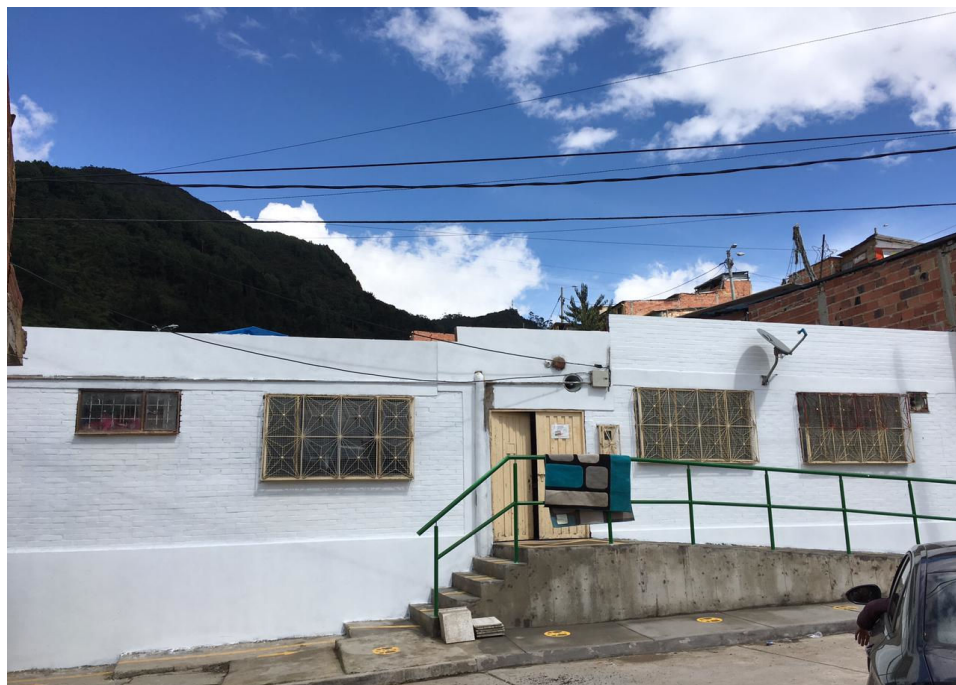
PINTURA SOBRE FACHADA
