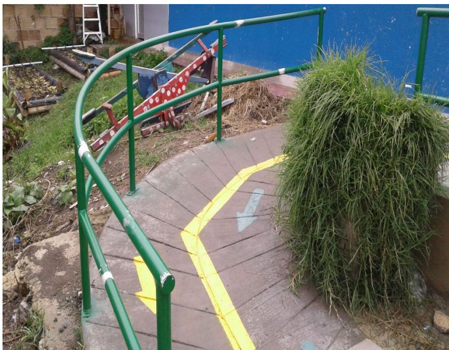
PINTURA DE ESMALTE SOBRE BARANDA INTERNA – ZONA DE JUEGOS
