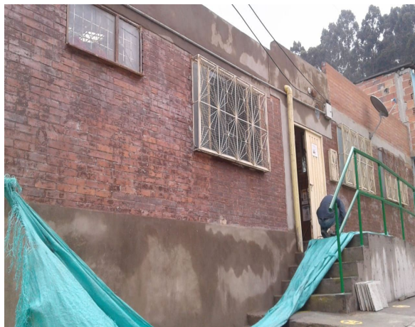
SE AJUSTAN FILOS EN TRAMOS DE FACHADA
