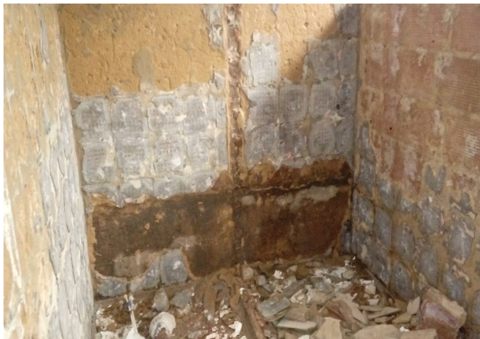
DEMOLICION DE MURO EN BLOQUE
