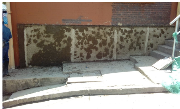
SE INICIAN ACTIVIDADES DE PAÑETE EN TRAMOS DE FACHADA
