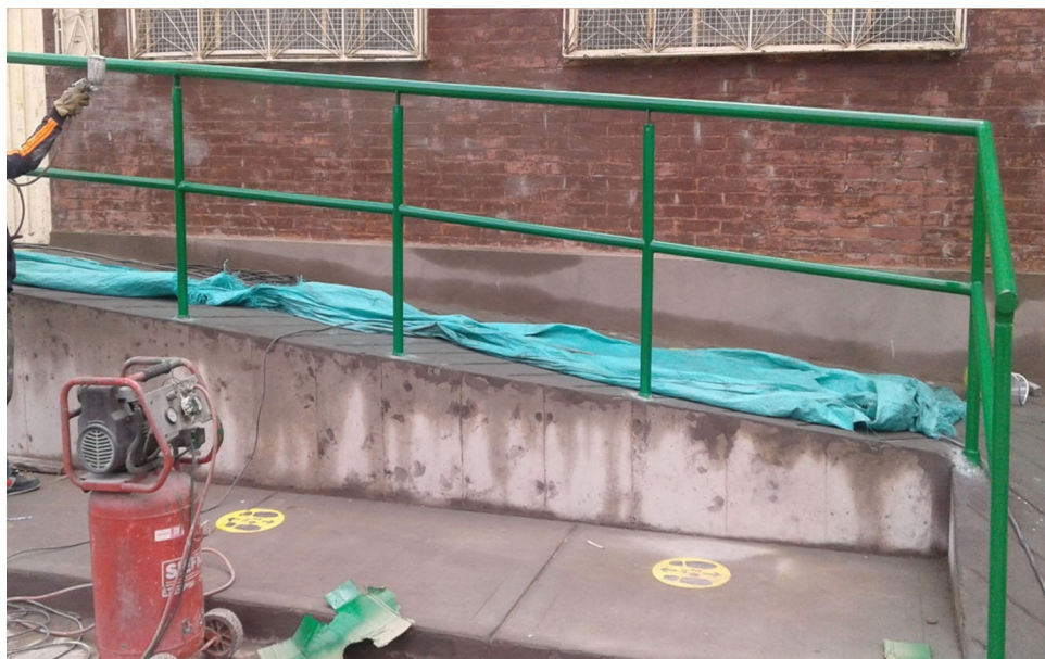
PINTURA DE ESMALTE SOBRE BARANDA EXTERNA
