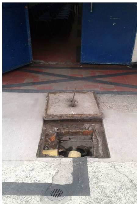
LIMPIEZA A CAJAS DE INSPECCION
