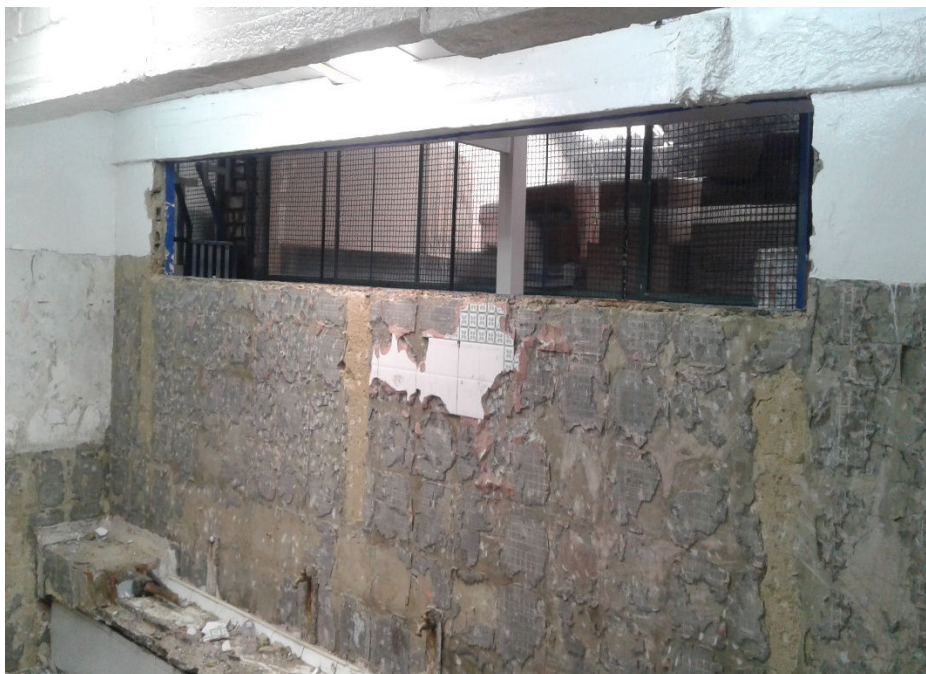
DEMOLICION DE ENCHAPE Y DESMONTE DE VENTANA
