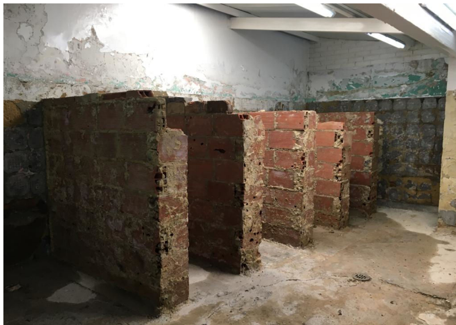
DEMOLICION DE PAÑETE
