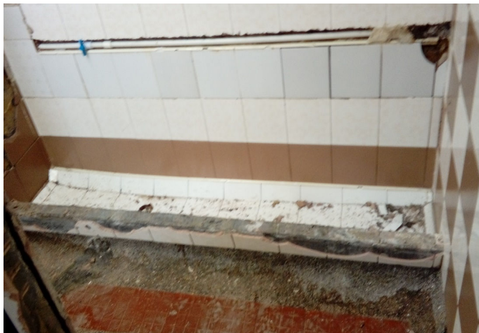
DEMOLICION DE ORINAL
