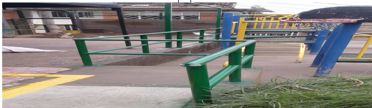
INSTALACION DE TRAMO DE BARANDA
