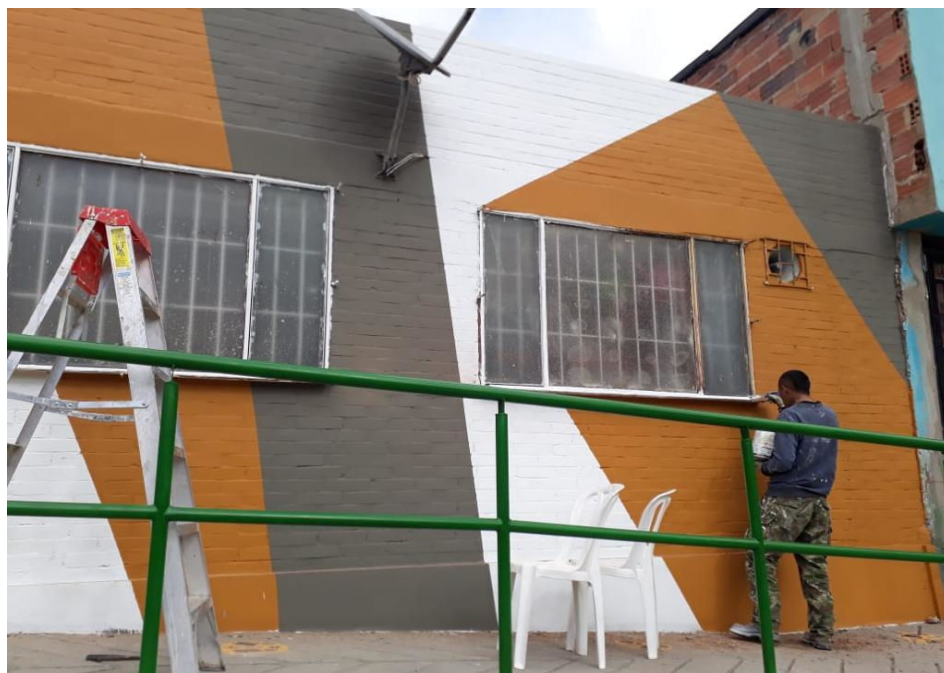
PINTURA SOBRE FACHADA
