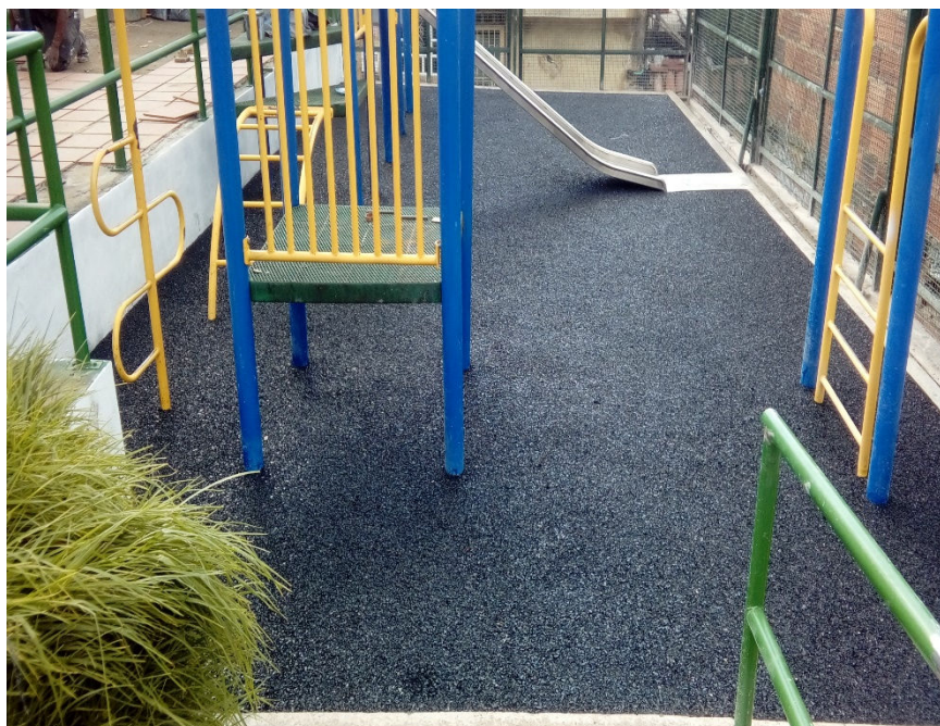
INSTALACION DE PISO CAUCHO BASE – ZONA DE JUEGOS
