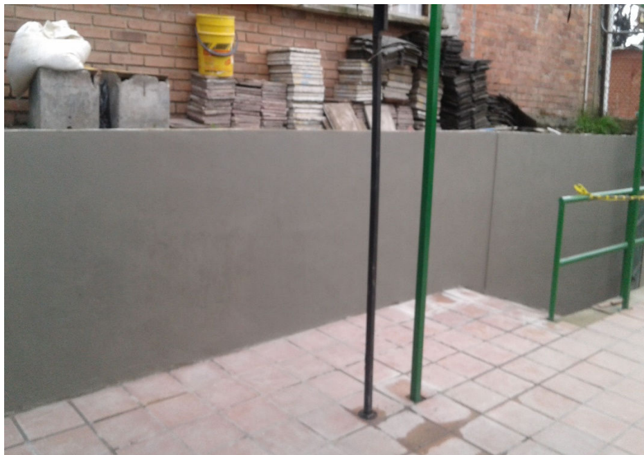
PINTURA EN MUROS INTERNOS – ZONA DE JUEGOS
