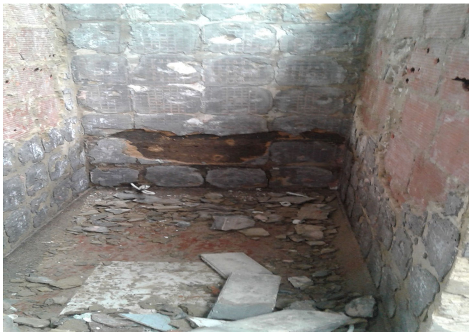
DESMONTE DE SANITARIOS
