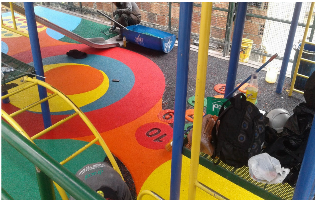
FIGURADO E INSTALACION DE PISO CAUCHO DE COLORES – ZONA DE JUEGOS
