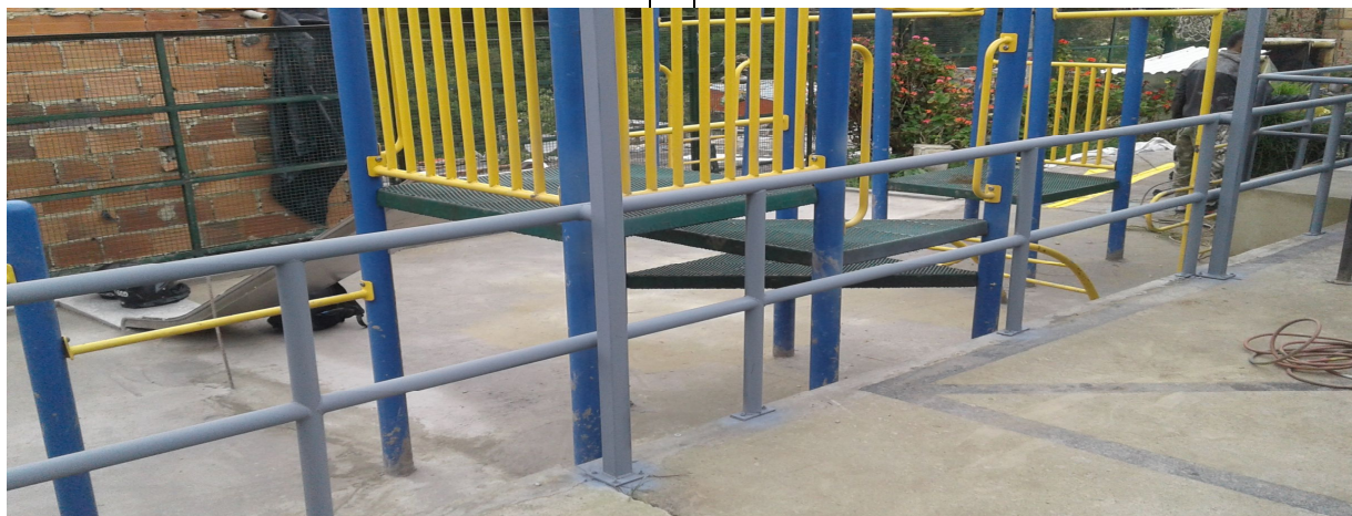
INSTALACION DE TRAMO DE BARANDA
