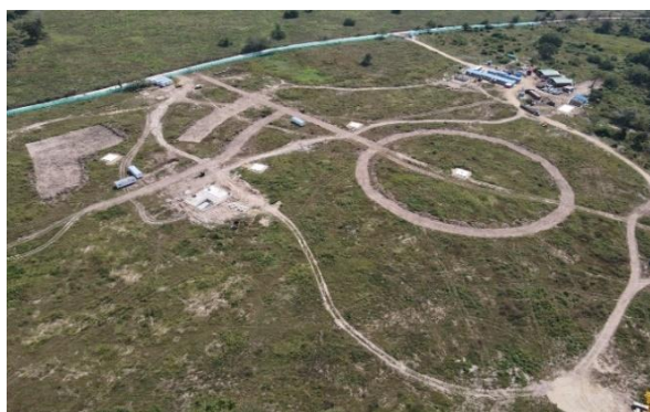
Imagen 25. Descapote de vías acceso No. 7
