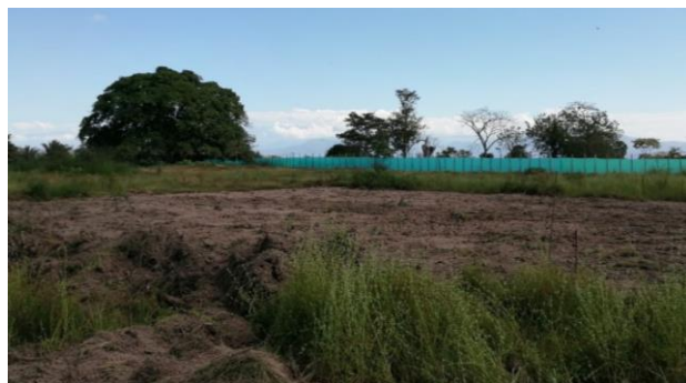
Imagen 11. Placa torre grúa N. 6
