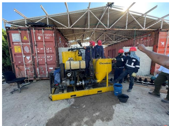
Imagen 10. Elaboración de probetas de la lechada agua/cemento según diseño entregado a interventoría Cemento: 42.5 Kg + 22 Lts de agua + 191 cc de Glenium + 191 cc Polyheed.
