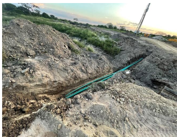
Imagen 2. Acometidas eléctricas para infraestructura.
