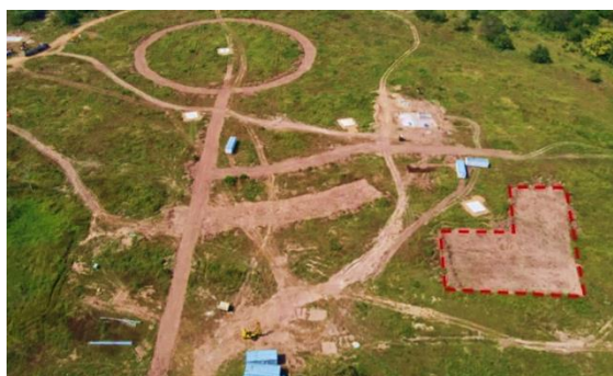
Imagen 13. Localización y descapote del edificio Administrativo y Alojamiento de Guardias, localización de micro pilotes para su replanteo e inicio.
