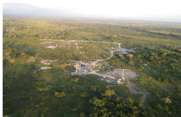
Imagen 24. Descapote de vías acceso Rotonda No. 8
