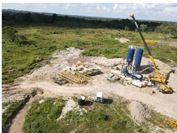
Imagen 1. Montaje de silos de planta de concreto
