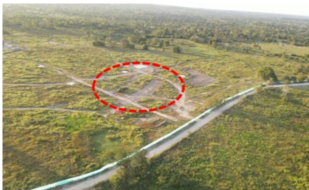
Imagen 16. Localización y descapote edificio guardia externa
