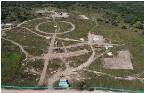
Imagen 23. Descapote de vías definitivas No 6.
