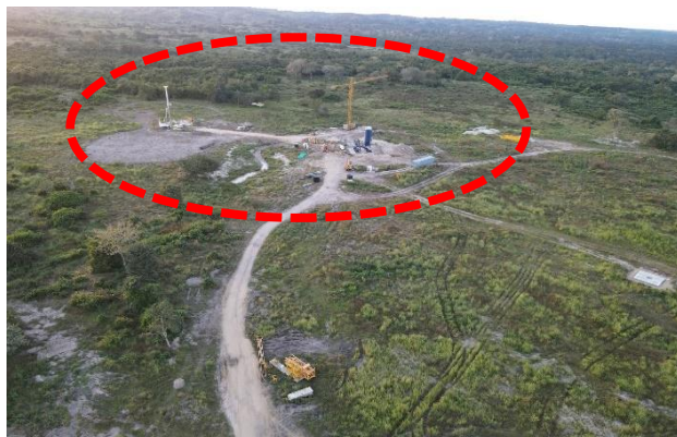
Imagen 18 y 19. Conformación vía de acceso para izaje de torre grúas T -1, T-2 No. 1 No. 2
