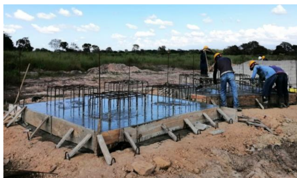
Imagen 6. Avance planta de concreto N. 2.
