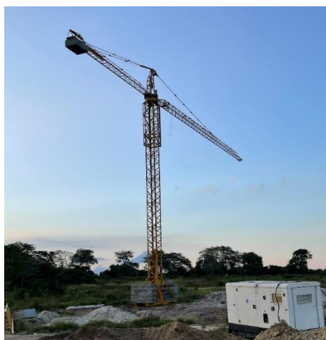
Imagen 7. Instalación de torre grúa 2, para planta de concreto.
