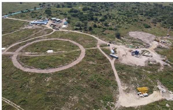
Imagen 22. Localización y replanteo vías definitivas
