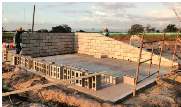
Imagen 5. Avance planta dosificadora.
