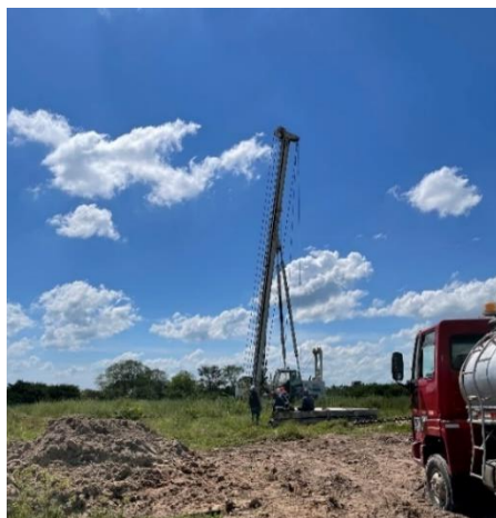
Imagen 9. Prueba de perforación para 9 Mt. Coincidencia entre el estudio de suelos y extracciones de terreno.
