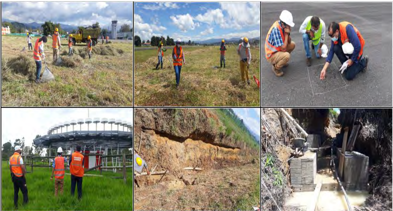
Fuente propia del Proyecto. Registro fotográfico semana del 01 al 07 de febrero.
