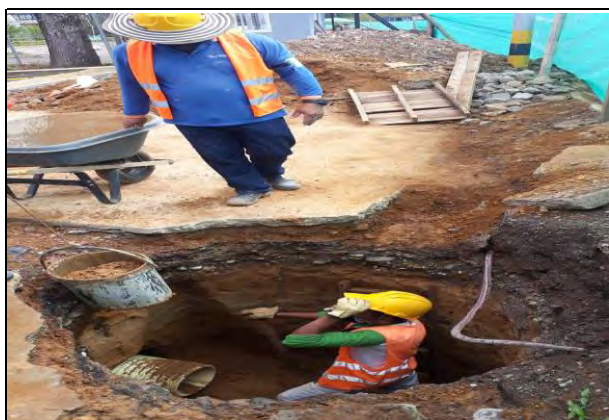
FOTO 5: SE CONTINUA CON EL PERFILAMIENTO EXCAVACION PARA RECAMARA ALCANTARILLADO PARALELO A SALA DE ESPERA - COVID
