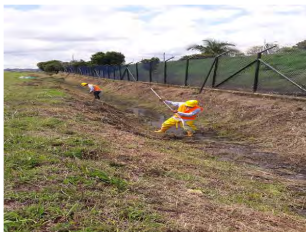
FOTO 10: LIMPIEZA DE CANALES
