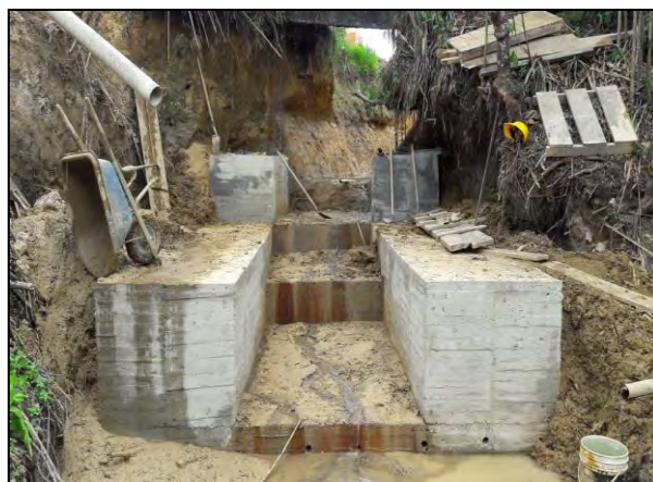
FOTO 4: DETALLE RECUBRIMIENTO GAVIONES ESTRUCTURA DE DESCOLE
