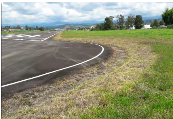
FOTO 11: REPASO DE ROCERÍA ZONA DE ILUMINACION BORDE DE PISTA
