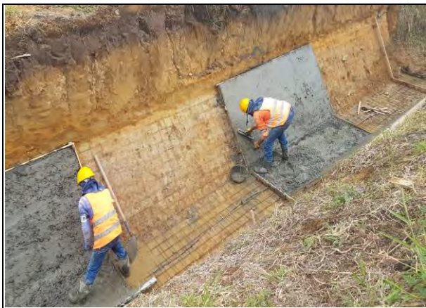
FOTO 1: INICIO FUNDICION REVESTIMIENTO DE CANAL
