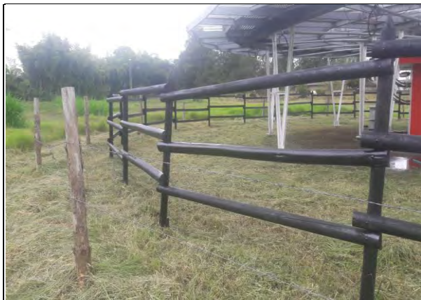
FOTO 7: ARREGLOS ZONA VOR CON MADERA INMUNIZADA E IMPERMEABILIZADA
