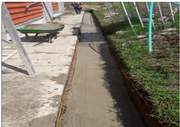
FOTO 11: INICIO FUNDICION PISO CANAL BOMBEROS
