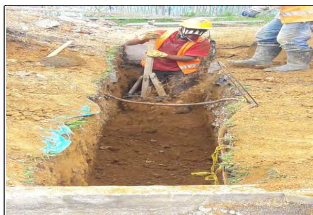
FOTO 5: LLENO DE EXCAVAIONES PARA ALCANTARILLADO PARALELO A SALA COVID
