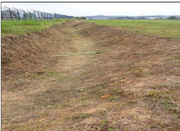
FOTO 9: LIMPIEZA DE CANALES
