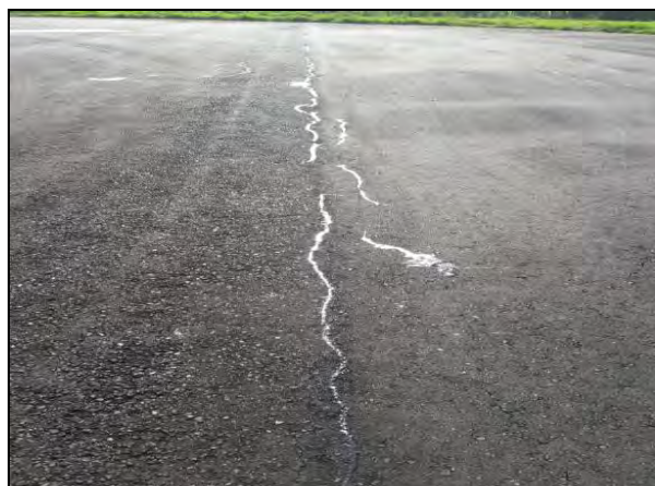
FOTO 10: SELLO DE FISURAS DE PISTA SIN RUTEO
