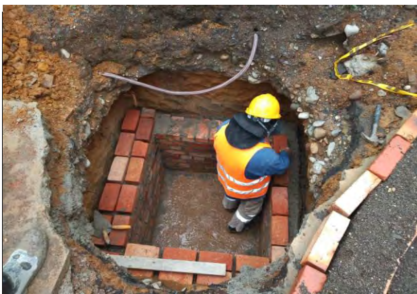
FOTO 5: INICIO CONTRUCCION CAJA DE INSPECCION ALCANTARILLADO
