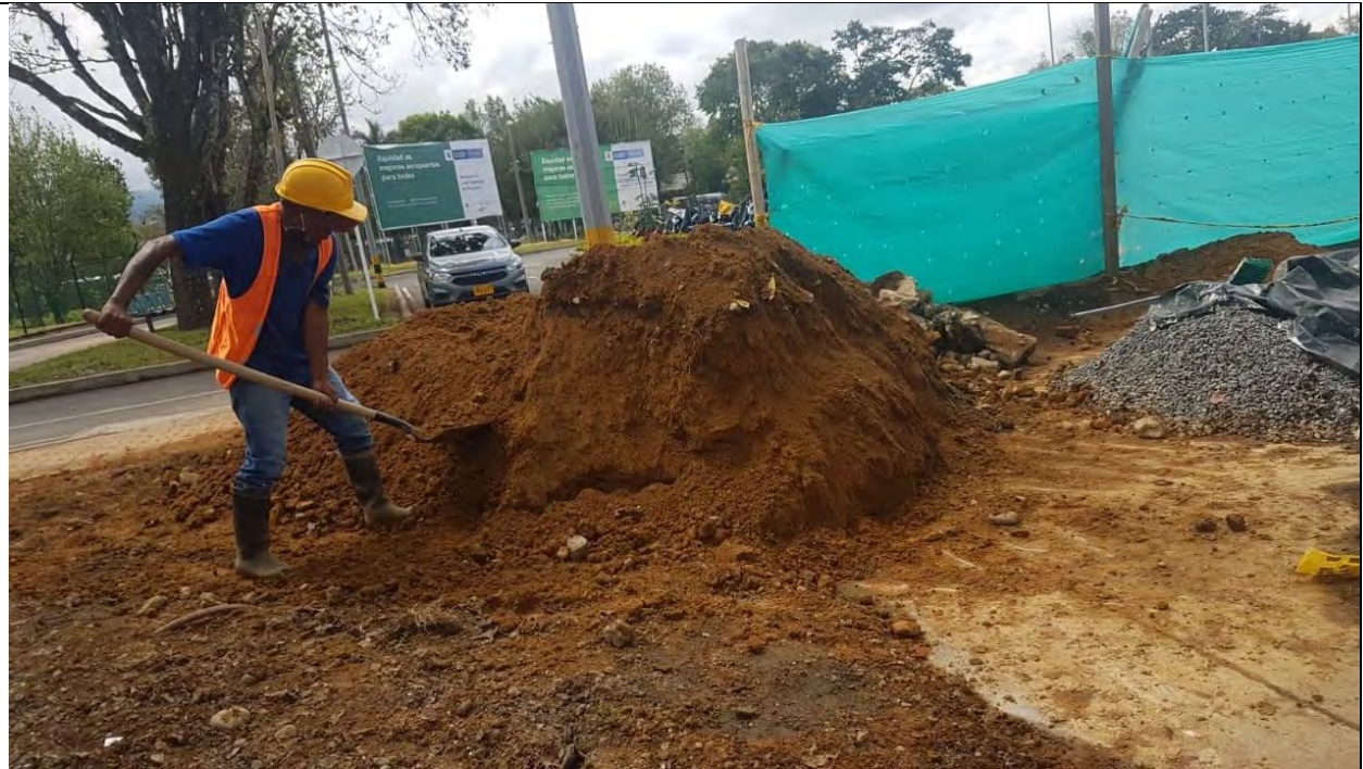
Fotografía 39. Material de construcción almacenado y usado exclusivamente para una jornada laboral
