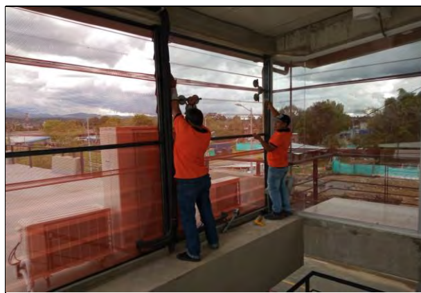
FOTO 6: INSTALACION DE VIDRIO TERRAZA BOMBEROS
