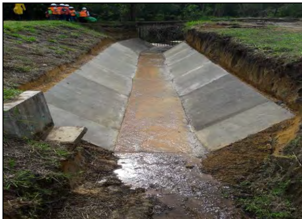
FOTO 1: TERMINACION REVESTIMIENTO DE CANAL ESTRUCTURA DE DESCOLE
