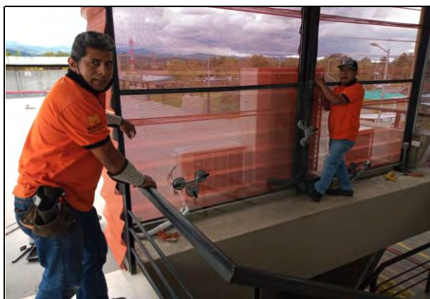
FOTO 5: INSTALACION DE VIDRIO TERRAZA BOMBEROS
