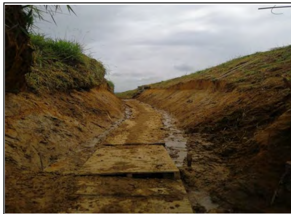
FOTO 8: PERFILAMIENTO DE CANAL PARA SU POSTERIOR RECUBRIMIENTO
