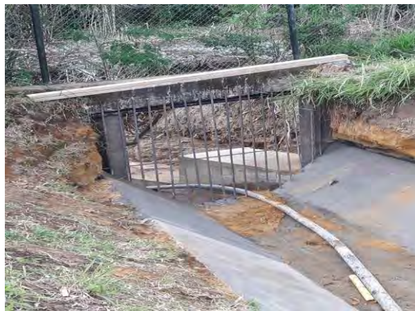
FOTO 4: INSTALACION VARILLAS 3/4 PARA REJA CANAL
