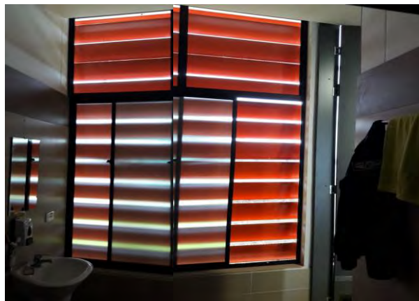
FOTO 12: INSTALACION DE VIDRIO HABITACION BOMBERO LORENA
