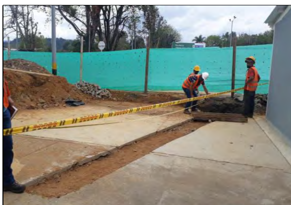
FOTO 6: LLENO DE EXCAVAIONES PARA ALCANTARILLADO PARALELO A SALA COVID
