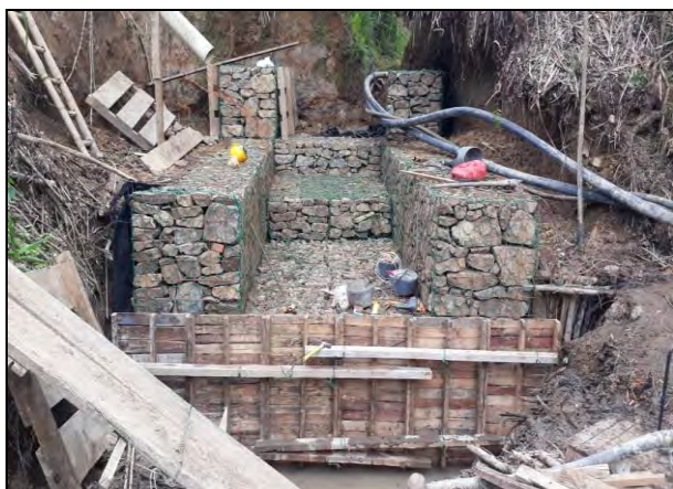
FOTO 3: SE CONTINUA CON CONSTRUCCION ESTRUCTURA DE DESCOLE GAVIONES LATERALES Y ENTREGA CANAL GAVIONES
