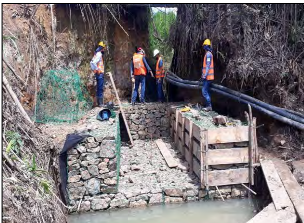
FOTO 10: SE CONTINUA CON LA CONSTRUCCION DE LA ESTRUCTURA DE DESCOLE EN GAVIONES
