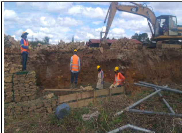
Fotografía 32. Generación de material sobrante en perfilamiento de talud
