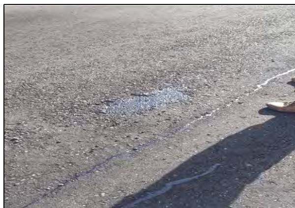
FOTO 12: SELLO DE FISURAS DE PISTA SIN RUTEO
