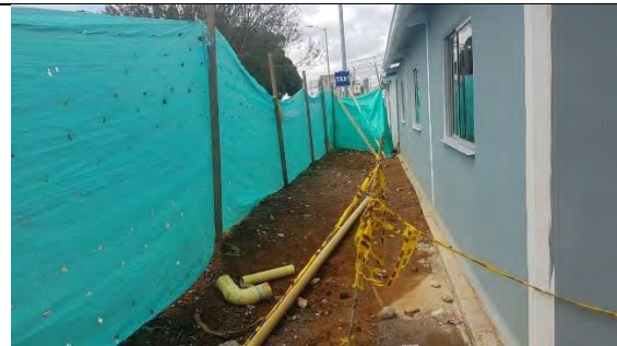
Fotografía 34. Material sobrante reusado para tapar zanja
