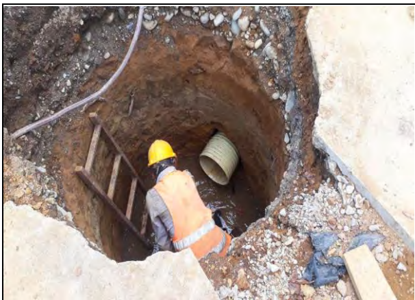
FOTO 7: INSTALACION DE TUBERIA D=12 " Y PERFILACION RECAMARA DE INSPECCION
