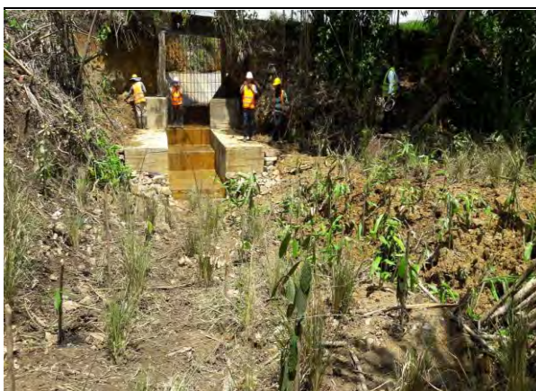
FOTO 10: COMPENSACION Y PAISAJISMO ZONA DE EXCAVACION ESTRUCTURA DE DESCOLE
