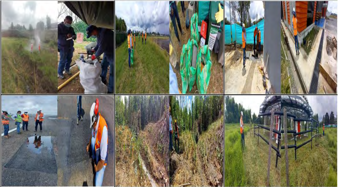
Fuente propia del Proyecto. Registro fotográfico semana del 15 al 21 de febrero.
