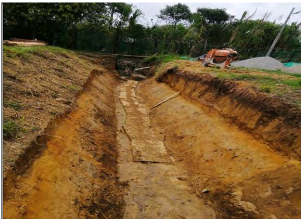
FOTO 7: PERFILAMIENTO DE CANAL PARA SU POSTERIOR RECUBRIMIENTO
