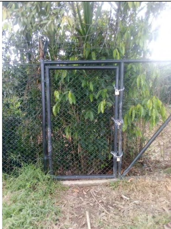
Fotografía 18. Puerta de acceso al área
