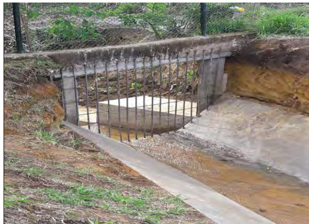
FOTO 2: TERMINACION REVESTIMIENTO CANAL, DETALLE REJA ESTRUCTURA DE DESCOLE
