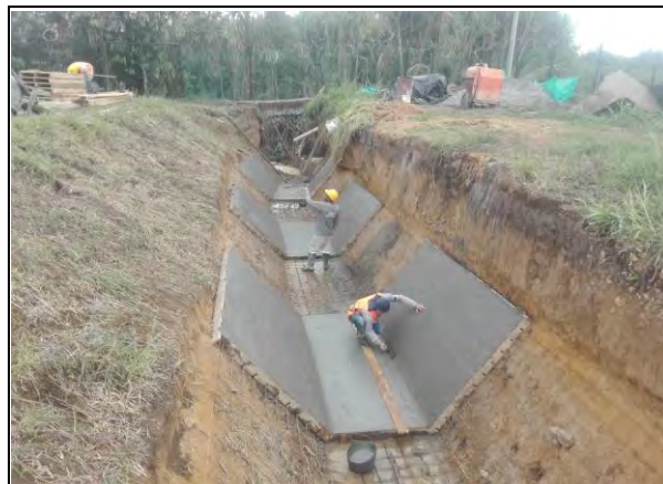
FOTO 2: FUNDICION REVESTIMIENTO DE CANAL POR TRAMOS
