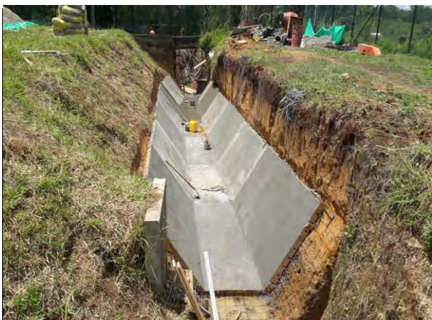
FOTO 3: CONTINUACION DE FUNDICION REVESTIMIENTO DE CANAL
