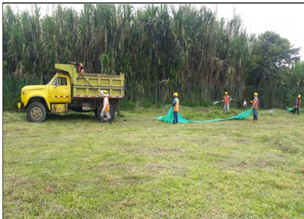
FOTO 1: CONTINUACION CON EL SEGUNDO CICLO DE ROCERIA CABECERA 08 Y SECTOR CANAL DERECHO EN SU INICIO
