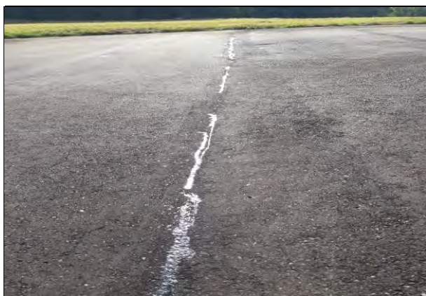
FOTO 11: SELLO DE FISURAS DE PISTA SIN RUTEO
