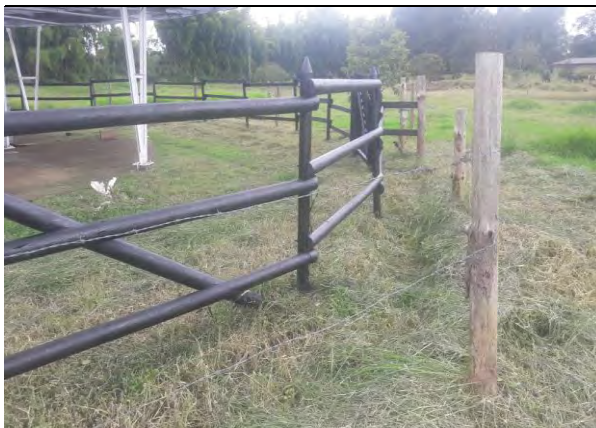
FOTO 8: ARREGLOS ZONA VOR CON MADERA INMUNIZADA E IMPERMEABILIZADA
