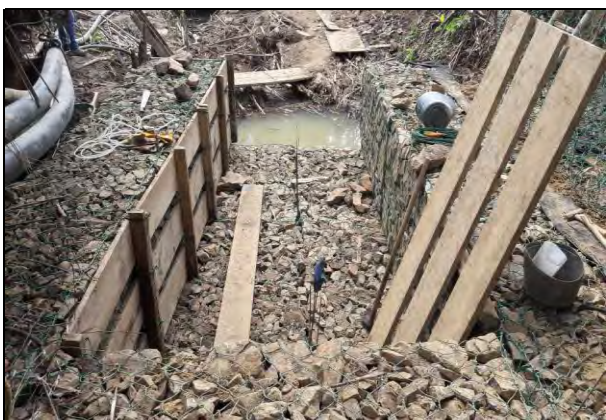
FOTO 11: DETALLE AVANCE ESTRUCTURA DE DESCOLE CANAL IZQUIERDO
