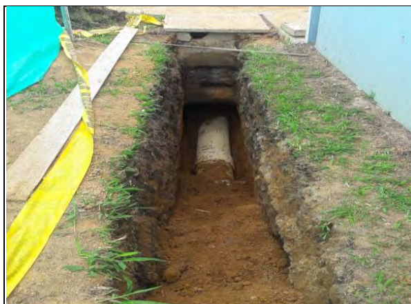
FOTO 4: INSTALACION DE TUBERIA ALCANTARILLADO AUXILIAR PARALELO A SALA PROVISIONAL COVID
